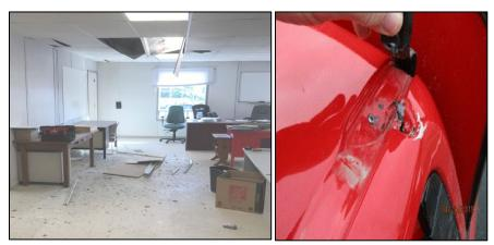
Figure 1 – Des éclats ont causé des dommages à un roulotte de chantier et à un camion stationné lors de deux incidents de dynamitage.
